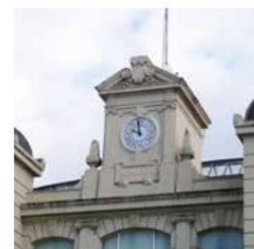
Stazione ferroviaria di Lerida, Spagna.
